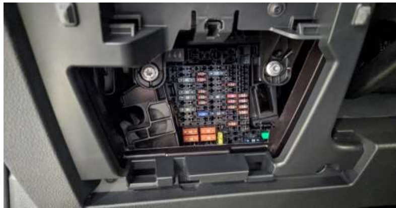
Figura 2. Caja de fusibles.
