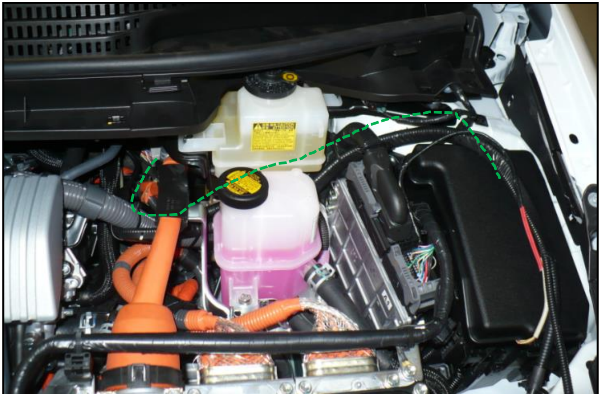
Del pasamuros a la caja de señales
