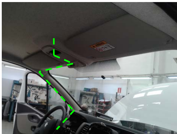
Fig. 10.1.2. Vista paso del cableado por el interior del techo hacia la caja adaptadora
