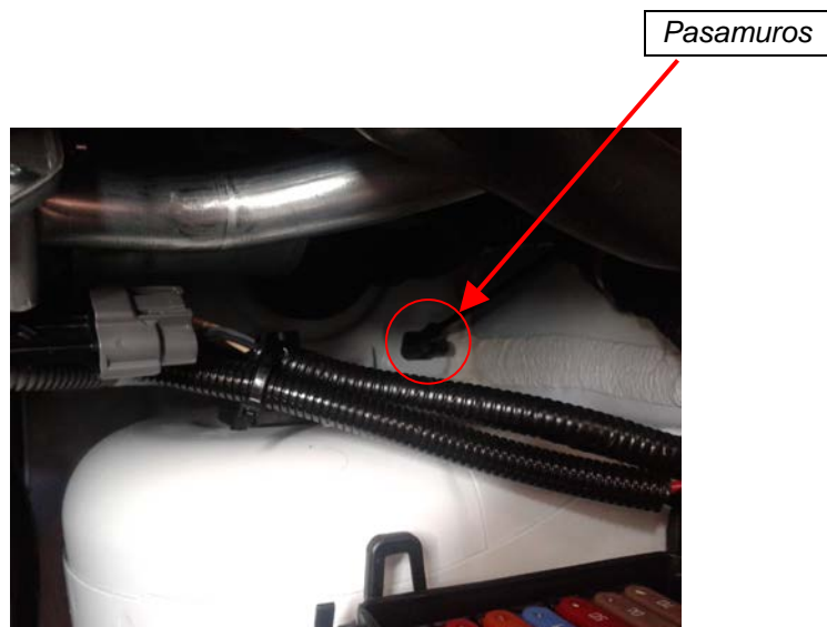
Fig. 1.3. Vista de la ubicación del pasamuros.
