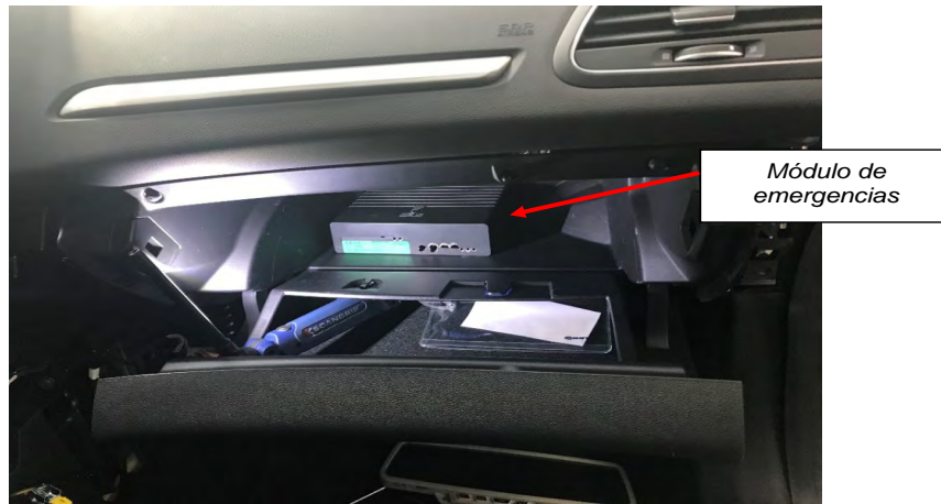
Fig. 7.1. Vista del emplazamiento del módulo de emergencias.
