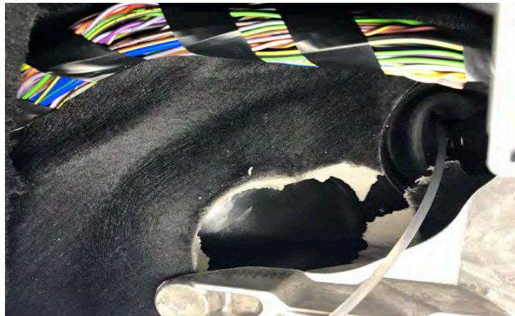
Fig. 2.4. Detalle paso cable de señal, vista habitáculo
