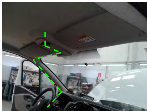
Fig. 9.2. Vista paso del cableado por el interior del techo hacia la caja adaptadora
