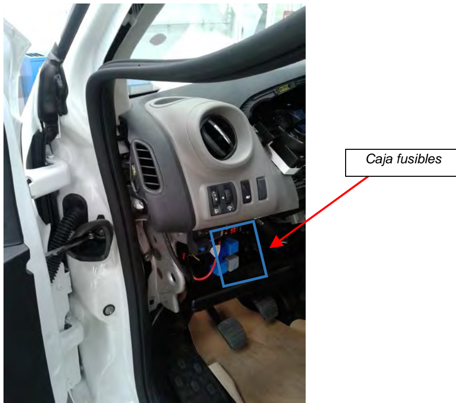
Fig. 3.1. Vista de la caja de fusibles, donde irá emplazada la caja conversor-adaptador.
