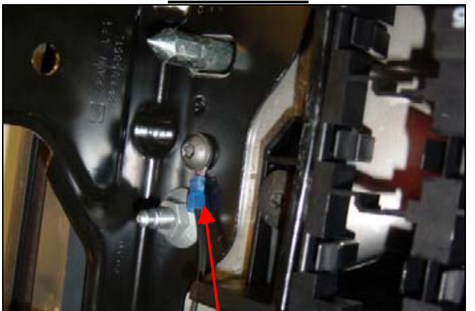
Cable de masa conectado
