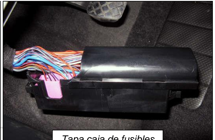
Tapa caja de fusibles
