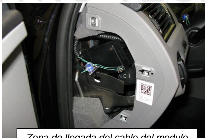
Zona de llegada del cable del módulo
