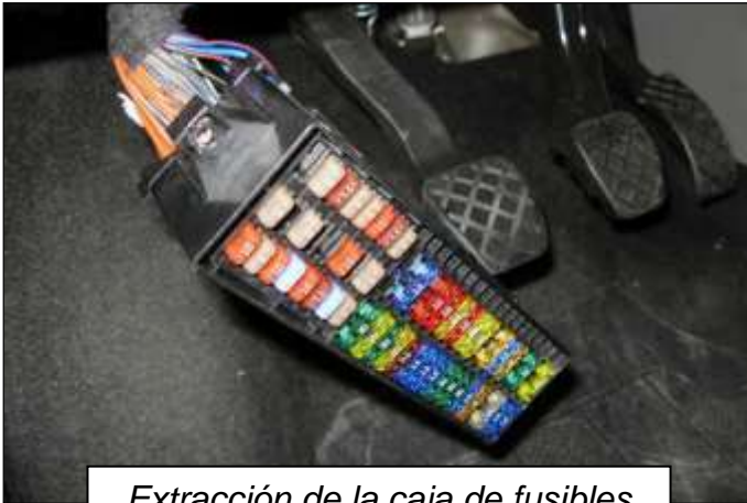
Extracción de la caja de fusibles
