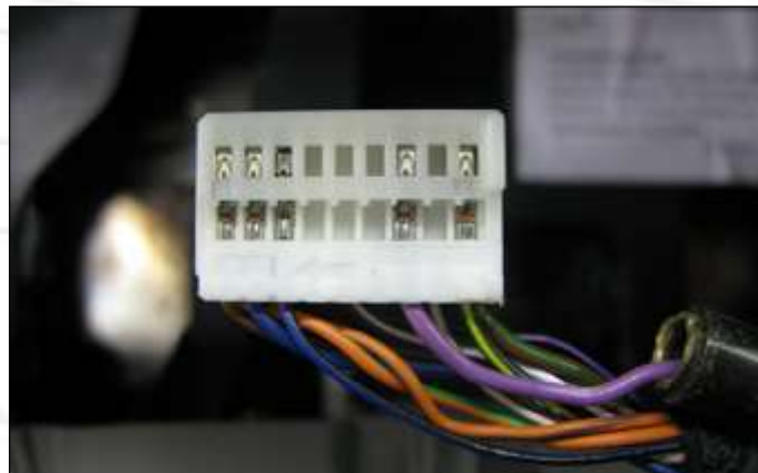
Conexión de la señal taquimétrica en el pin nº 3
