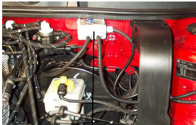
Caja de conexión
