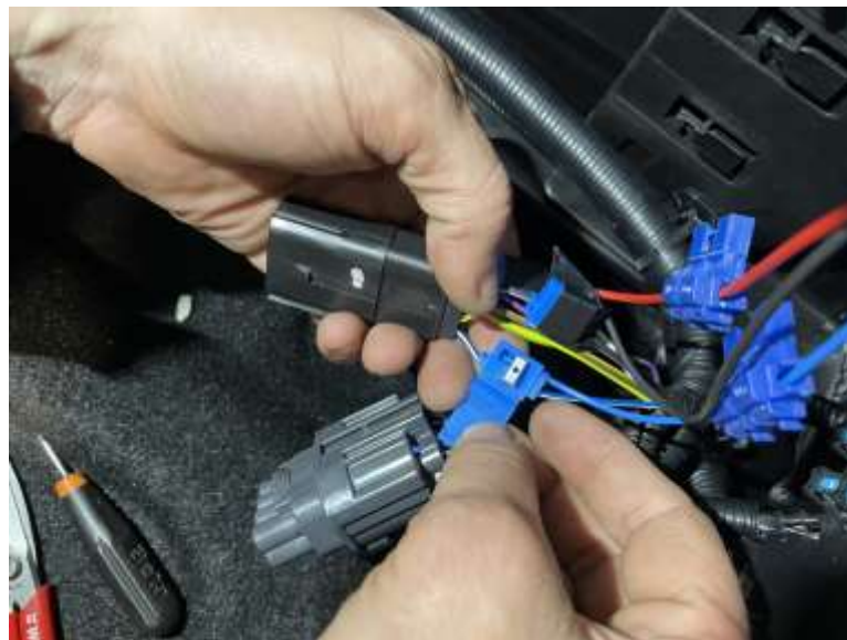
Desdoblamiento del cable
