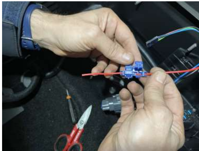
Colocación del Fusible
