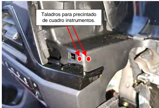
Fig. 3.1. Taladros precintado cuadro de instrumentos.
