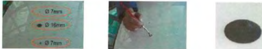
Fig. 5.5.1.6. Zona de taladros para el módulo tarifario atornillado desde el exterior.
