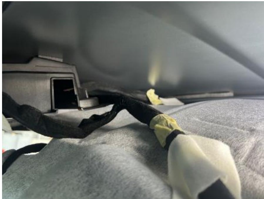
Fig. 5.4.1.6. Vista de la zona a taladrar tras la estructura del plafón del techo.
