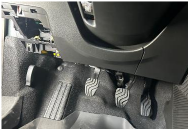
Fig. 3.4.1.3.2. Acceso a la caja de fusibles
